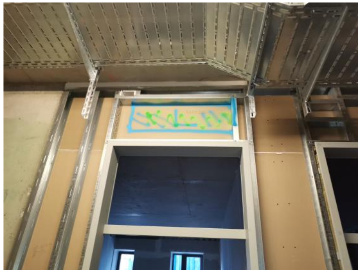
Wurde nach ARC gebaut Abweichung 5 cm W+M und ARC 15.01.131
